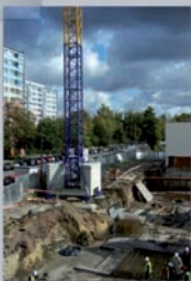
Powstają fundamenty, październik 2009 r.
