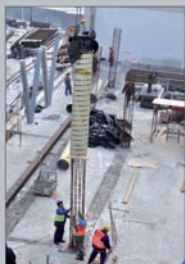
Montaż podpór, wrzesień 2010 r.
