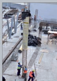
Montaż podpór, wrzesień 2010 r.
