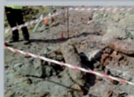
W trakcie wyburzania natrafiono na cztery niewybuchy.
