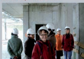
Wizyta na budowie.
