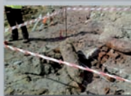
W trakcie wyburzania natrafiono na cztery niewybuchy
