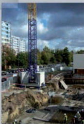
Powstają fundamenty, październik 2009 r.
