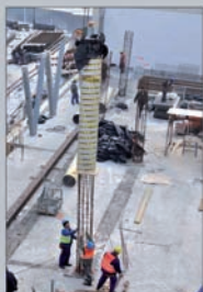
Montaż podpór, wrzesień 2010 r.
