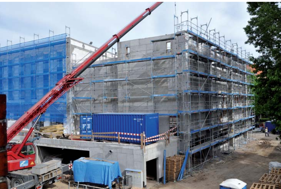
Budowa CKU (maj 2012)
